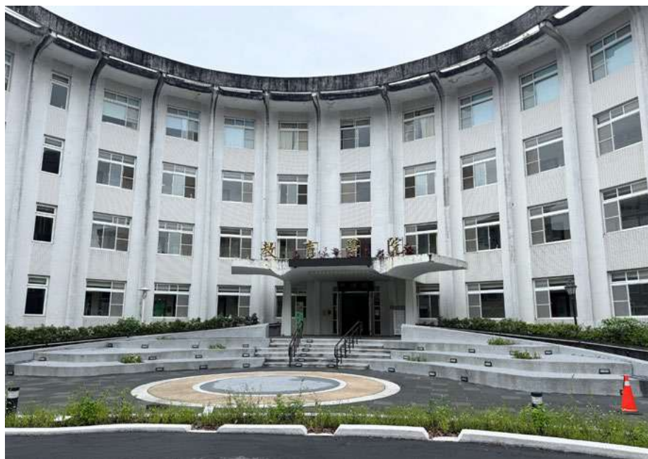
左下圖：教育學院前木平台改善計畫拆除原有腐敗潮濕的木棧平台，改設置透水鋪面、雨水花園，增加校園綠色基盤增進休憩、貯水、降溫等功能。（來源：政大總務處）
