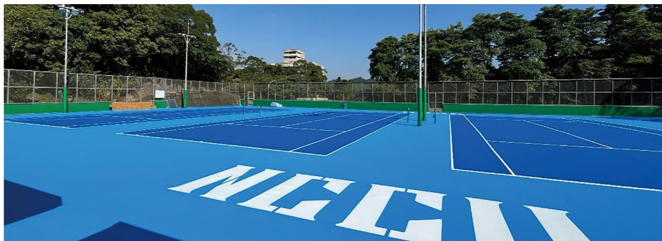
2023 年環山運動園區設施改善（六期丙區平台地坪及網球場涼亭補強工程）
