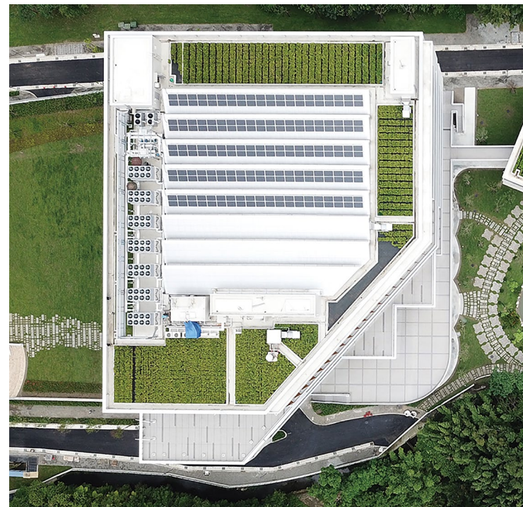
達賢圖書館屋頂太陽光電板
